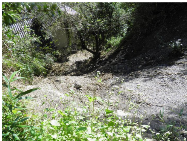
写真1 崩壊の地上部からの住宅裏の状況
