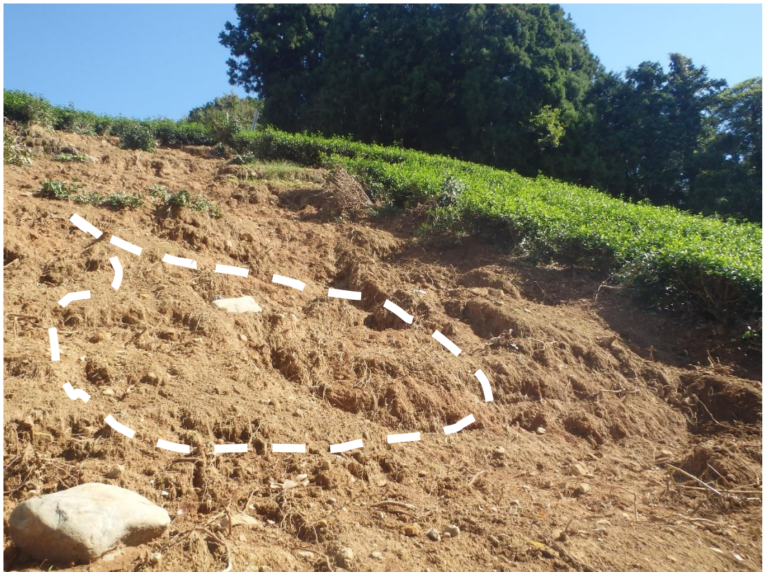
写真-4 : 地下水湧出痕～下方流下雨裂
